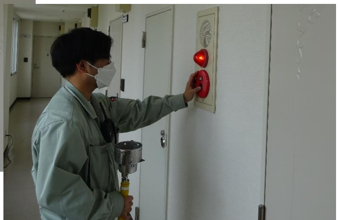
非常ベルの点検
