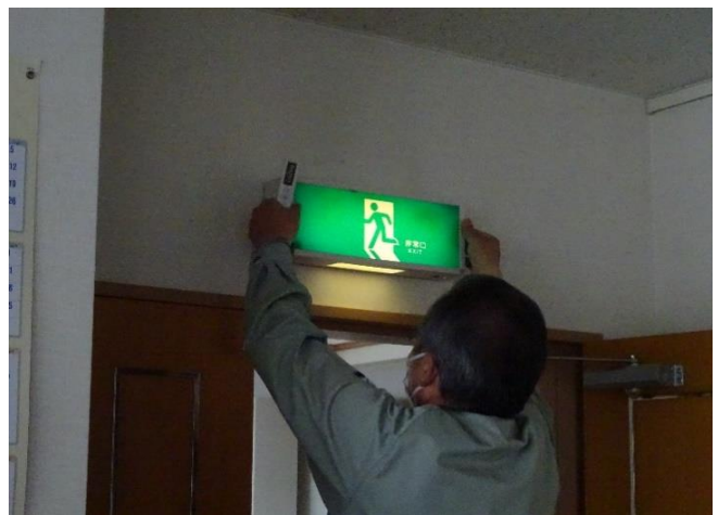
誘導灯の交換
