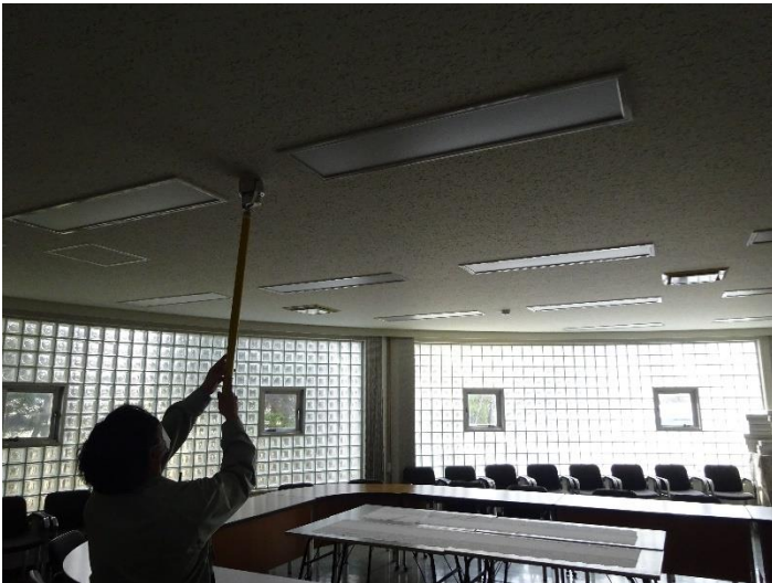
大会議室の点検
