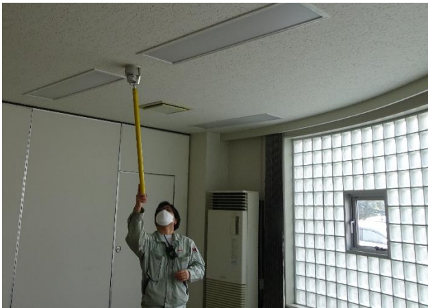
小会議室の点検
