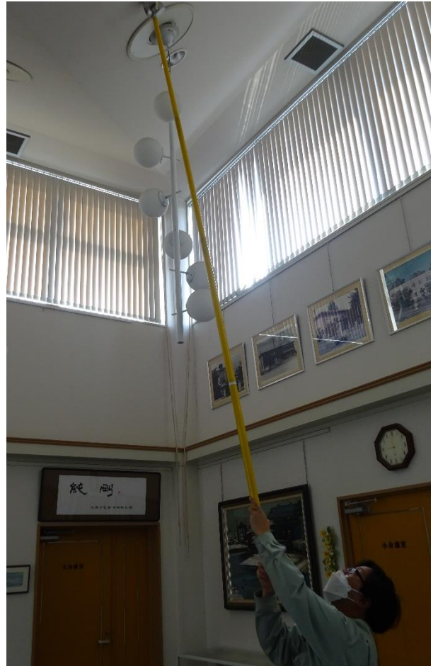
北師会館ホールの点検
