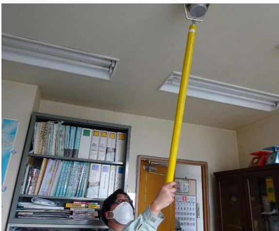
事務室の点検
